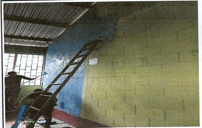
Foto 4: Mejoramiento de pintura en muros exterior e interior
