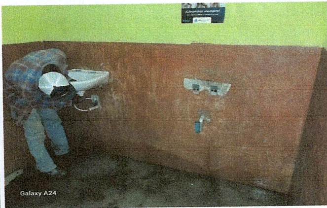
Foto 3: Mejoramiento de servicios Sanitarios y sus accesorios
