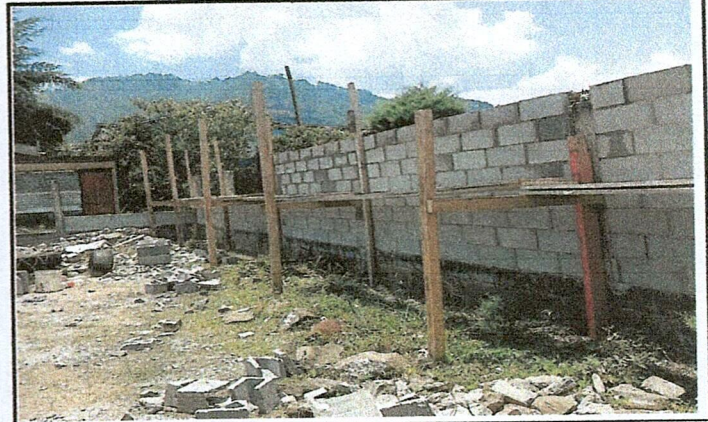
Foto 2: Mejoramiento de Muro Perimetral en Proceso
