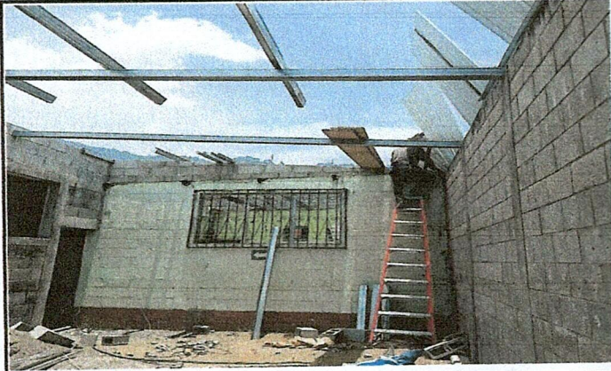
Foto 1: Remozamiento General de aula en proceso
